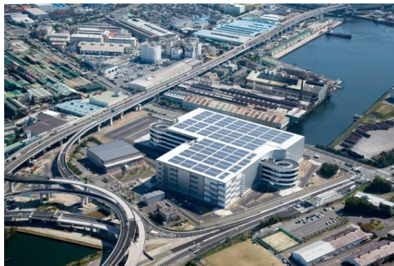
バンダイホビーセンター大阪 外観（三井不動産ロジスティクスパーク堺の一角に設立）
